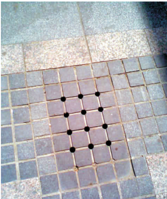
Fig. 37 – Drenazh që është në nivel të njëjtë me brezat e biçikletave
