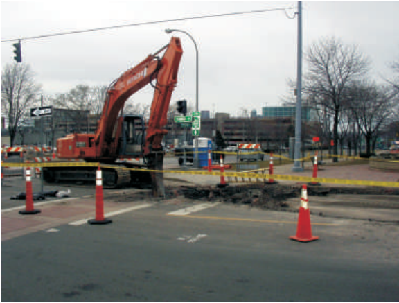
Fig. 36 – Përmirësimi dhe renovimi konstruksionit të aksit
